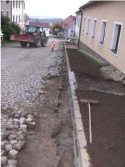
Im Zuge dieser Baustelle wurde auch gleich die Stützmauer beim Haus Göß neu errichtet und mit einem Geländer versehen. Ebenso wurden der Regenwasserkanal saniert, EVN Verkabelungen vorgenommen, eine neue Stromversorgung für den Adventmarkt und eine neue Ortsbeleuchtung installiert. Danke an alle Helfer beim Zusammenbauen und Aufstellen der Ortslampen!
