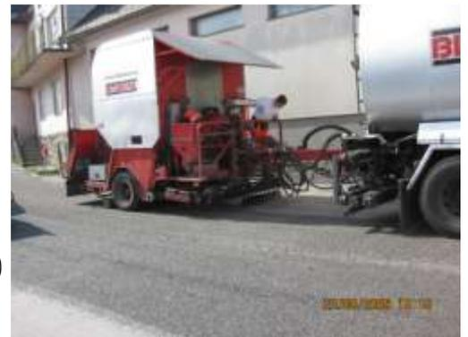
Auf rissigen bzw. ausgemagerten Asphaltdecken wurde eine selektive Oberflächenspritzung aufgebracht.
